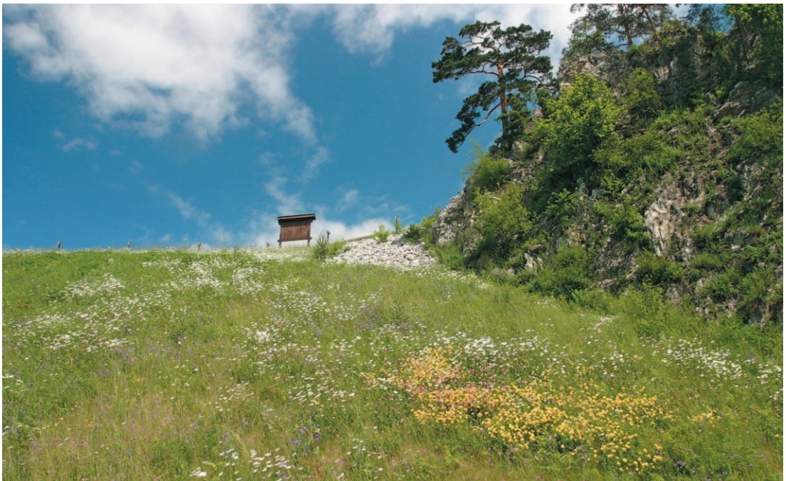
Fot. 2. Skarpa odpowietrzna zapory. Crest of the dam.
