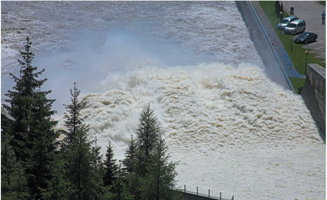
Fot. 1. Praca przelewu w czasie powodzi. The overflow operating during the flood.
