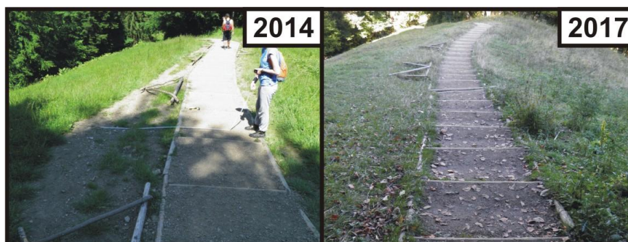
Fot. 2. Zastosowanie specjalnych zabezpieczeń przed rozdeptywaniem bocznym szlaku przez turystów umożliwił szybką regenerację pokrywy roślinnej na szlaku Kosarzyska-Polana Pieniny The use of special protection constructions against the tourist dispersion allowed the plants to regenerate quickly on the blue trail from Kosarzyska to the Pieniny glade
