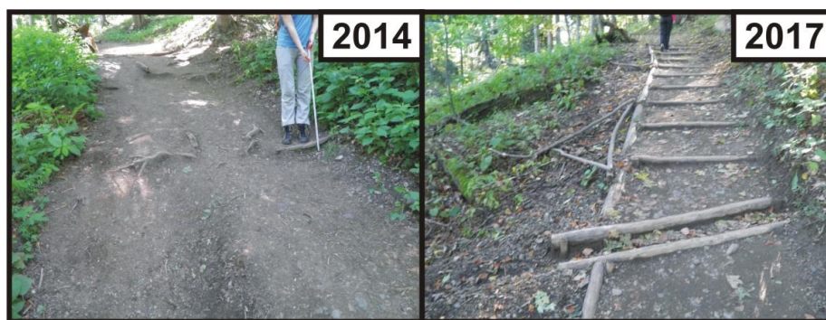
Fot. 1. Zastosowanie drewnianych progów, krawężników, przepustów wodnych oraz przeszkód w celu ograniczenia procesów erozyjnych na szlaku Kosarzyska-Polana Pieniny The use of wooden thresholds, curbs, culverts and obstacles to reduce erosion on the blue trail from Kosarzyska to the Pieniny glade
