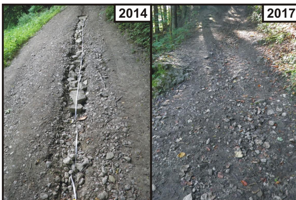
Fot. 12. Bruzda erozyjna zmodyfikowana przez człowieka w dolnym odcinku szlaku Kras-Sosnów Erosion furrow modified by human at the bottom part of the green trail from Kras to the Sosnów pass
