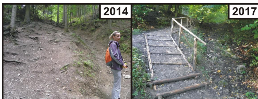
Fot. 9. Fragment szlaku Kras – Sosnów w obrębie stromego stoku charakteryzował się tak silną degradacją, że niezbędne okazało się wytyczenie nowej trasy, omijającej niebezpieczne miejsce The fragment of the trail from Kras to Sosnów pass in the steep slope was characterized by such a strong degradation that it was necessary to set out a new route, bypassing a dangerous place
