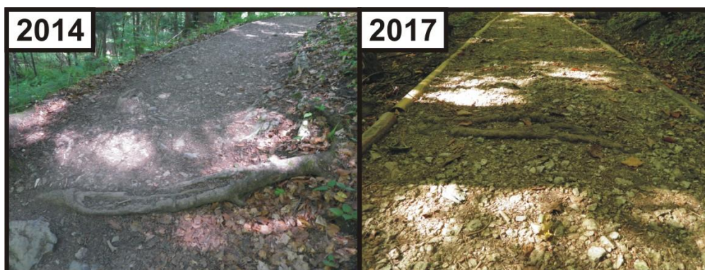
Fot. 17. Remont nawierzchni szlaku turystycznego umożliwia ukrycie wystających i uszkodzonych korzeni drzew
