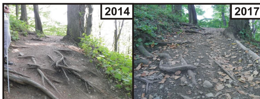
Fot. 3. Próba ukrycia zniszczonych korzeni drzew pod nową nawierzchnią szlaku w środkowej części trasy z Kosarzyska na Trzy Korony An attempt to hide the wiped tree roots under the new trail surface in the middle of the route from Kosarzyska to the Pieniny glade
